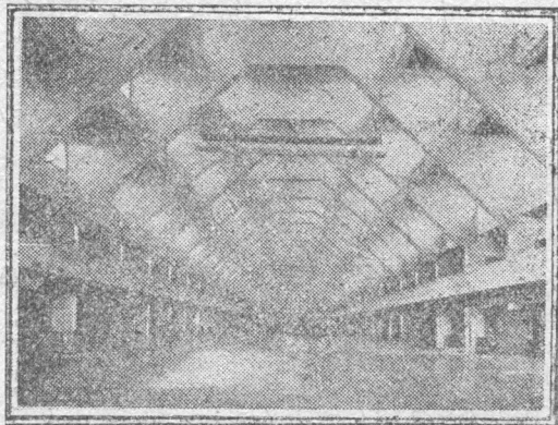
Радиостанция в Берлине. Металлическая конструкция заменена деревянной
